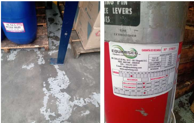
Fotografía 4. Bodega 37, Estado pisos. Fotografía 5. Bodega 37, extintor vencido. Empresa ARINTIA GROUP SAS, municipio de Funza. Fuente: Propia.
